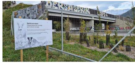
Document 3. Le passage à faune (en 2 sur la carte de localisation) vu du niveau de l'autoroute
