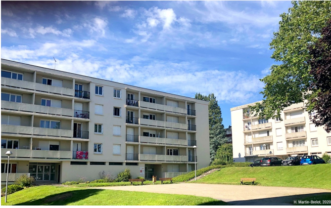
Kergoat : Logements de la Caisse des Dépôts et Consignation en ravalement. Cliché : Hélène Martin-Brelot, juillet 2020.
